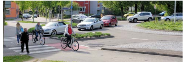
Fußgänger können in der Ausfahrt einen Stau verursachen, der die Kapazität erheblich reduzieren kann.
